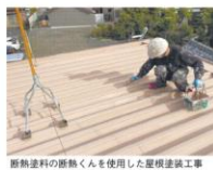
断熱塗料の熱断熱を使用した屋根塗装工事
