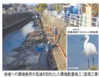
地域への環境負荷の低減を目的とした環境配慮型施工(浸透工)
