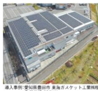
導入事例:愛知県豊田市長 東海カメット工業株式会社 電圧工場 300kW
