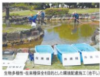
生物多様性-在来種保全を目的とした環境配慮型施工(池干し)
